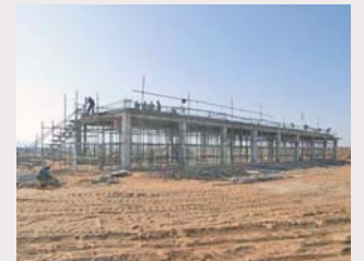
建設中の新プラント
