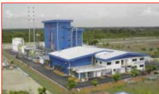
包装用接着剤 8,000t/y新設 完工03年7月 営業運転03年11月
