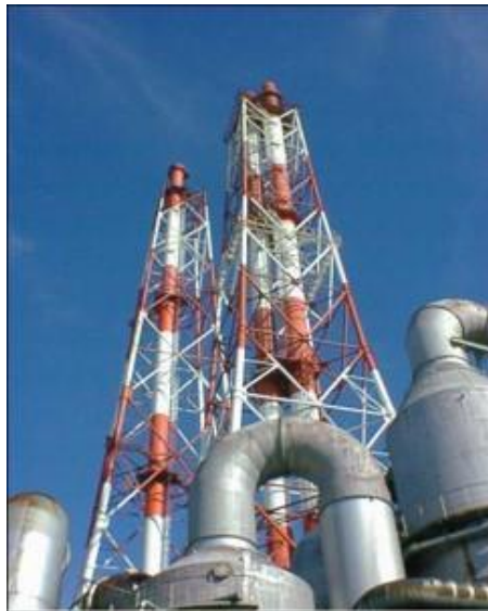
三井化学大阪工場の大規模ボイラープラント
