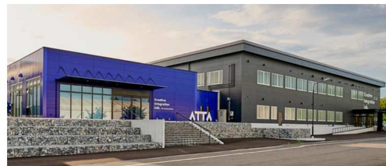
クリエイティブインテグレーションラボ®外観
