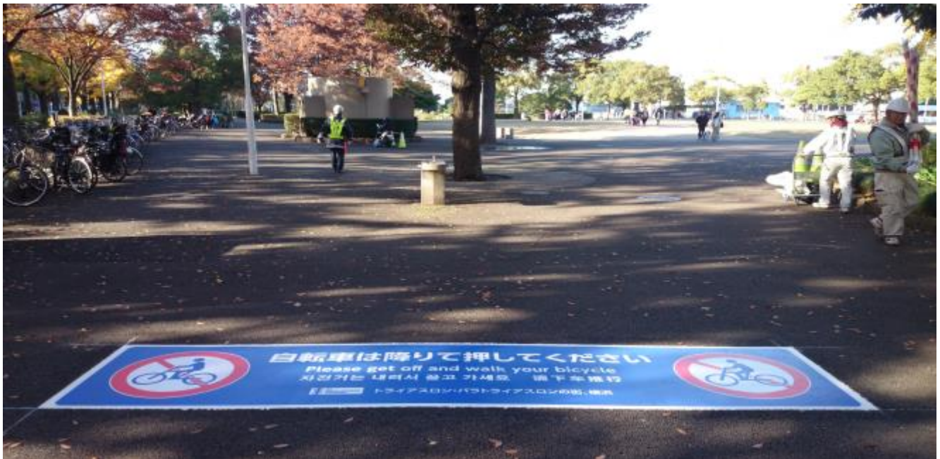
（横浜・山下公園のシリカルアート施工現場、4,000mm×900mm サイズ）
