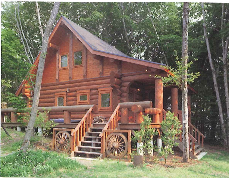
ログハウス (山梨) 写真提供/(株)アールシーコア BESS事業本部
