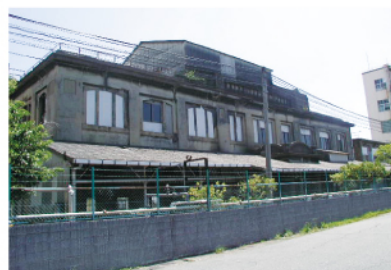
ポリエチレンの研究を行った旧開発試験棟
