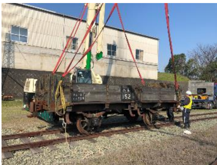
無蓋車の移設作業の様子
