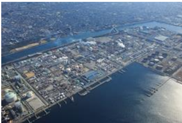
三井化学大阪工場
