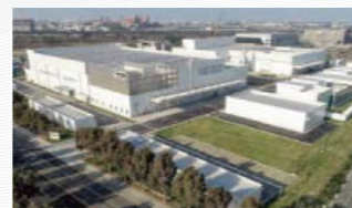
台湾に完成した新工場
