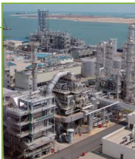
ミツイ・フェノールズ・シンガポール社のフェノールプラント
