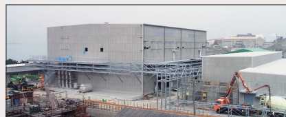
建設中の新工場
