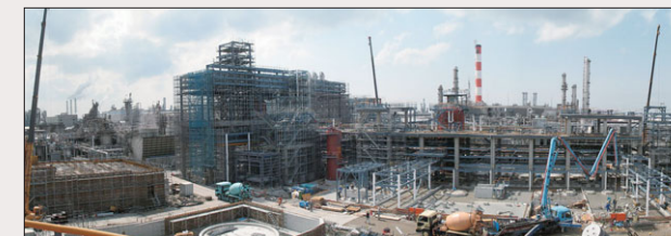
建設中の新プラント
