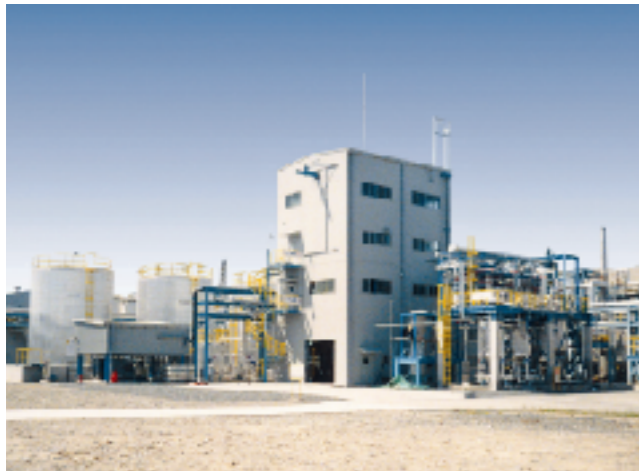
完成した新プラント
