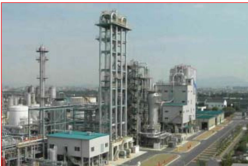
(完成したPPプラント)
