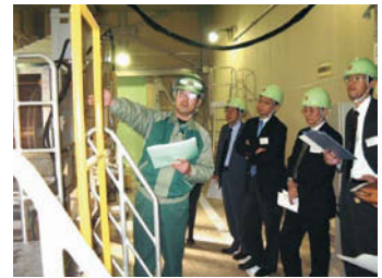
労使環境安全フォーラムの現場/ハトロール
