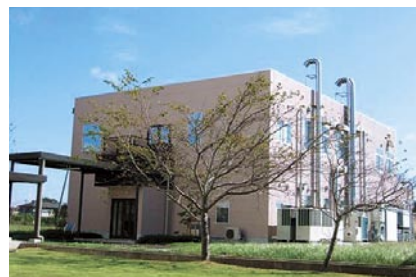
製品安全センター試験棟
