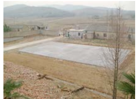
造成中のグラウンド
