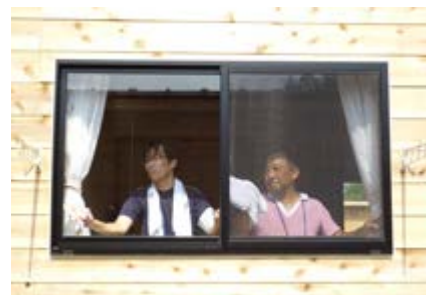
熱遮断フィルム貼付作業
