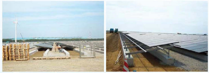
80万㎡の広大な敷地でのソーラーパネル設置風景。
