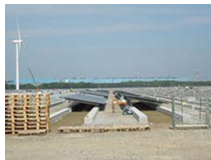
80万平方メートルの広大な敷地でのソーラーパネル設置風景
