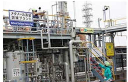
蒸留塔での運転準備
