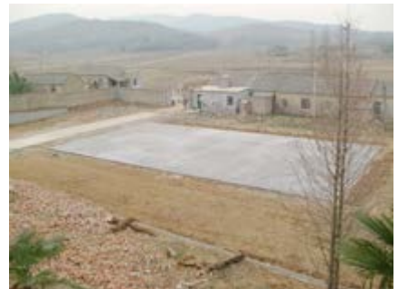
造成中のグラウンド
