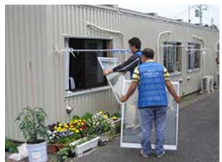
熱遮断フィルム設置作業の様子
