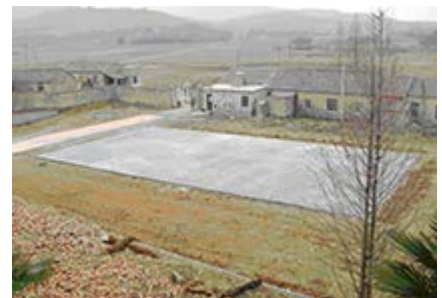
造成中のグラウンド
