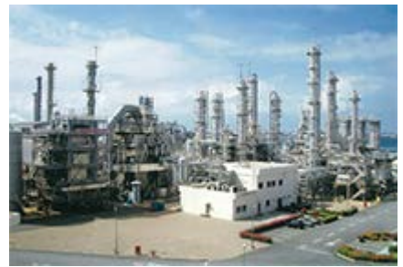
シンガポールのジュロン島にあるMPSの製造プラント
