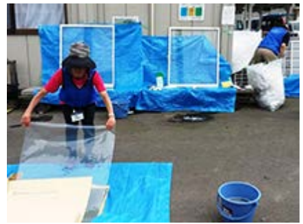
屋外で窓のサイズに合わせたフィルムを1枚ずつ貼り付け
