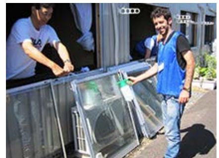
二重サッシの外側の窓へフィルムを貼り付け
