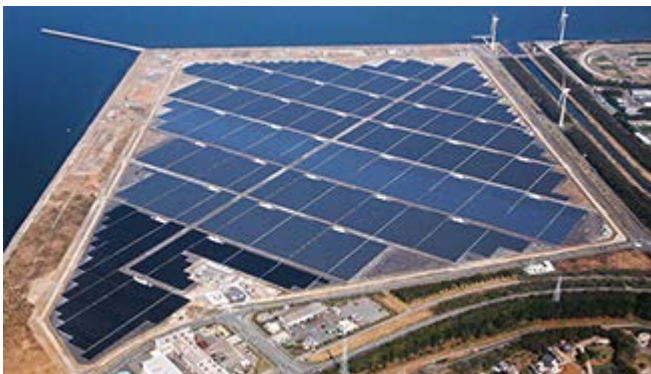
たはら太陽光発電所 <2014年3月 撮影>
