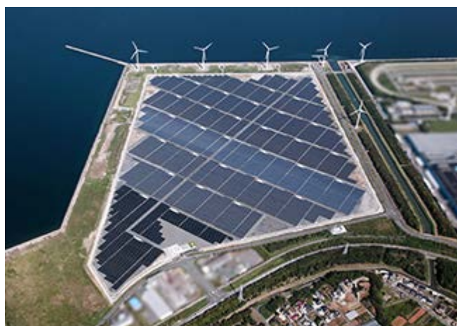
たはら太陽光発電所 <2014年9月撮影>
