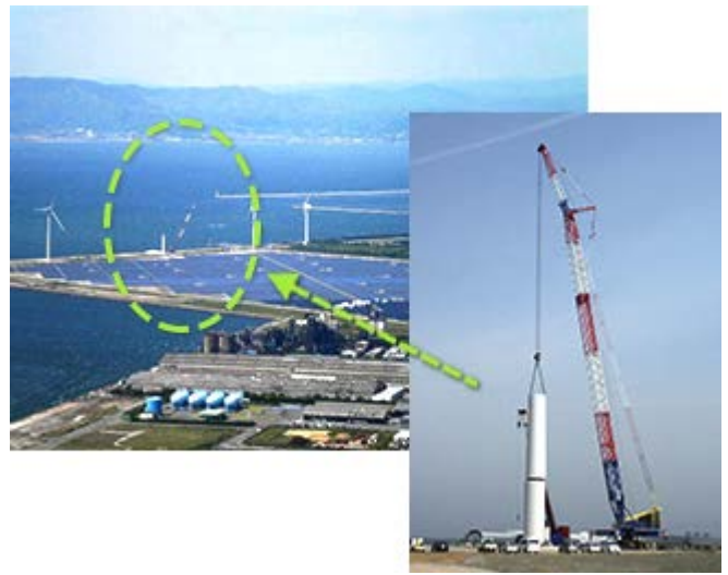
蔵王山展望台から見る発電所（左）と 風車タワー組立工事（右） <2014年5月 撮影>
