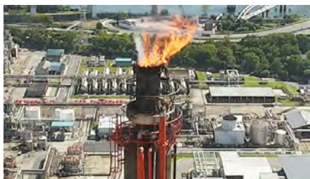
ドローンによる点検作業
