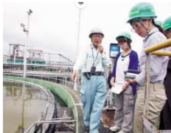
活性汚泥処理の後段階。コイも住めるように処理がされている。このあと海に放流する。
