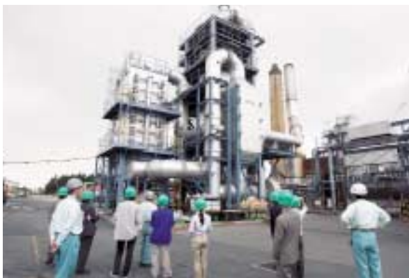
ダイオキシンが出ないように設計された焼却炉。
