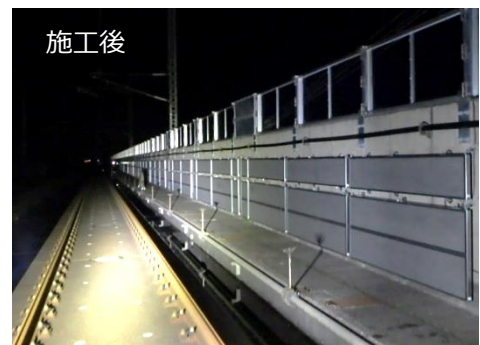
全天候型吸音材を使用した吸音板施工例（上越新幹線 散水区間）
