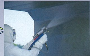
2液衝突混合スプレーガン
