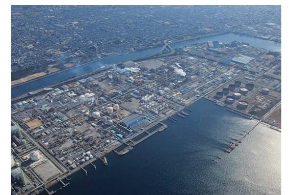
バイオマス誘導品を生産する三井化学大阪工場。
